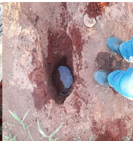
INFILTRAÇÃO DA ÁGUA
