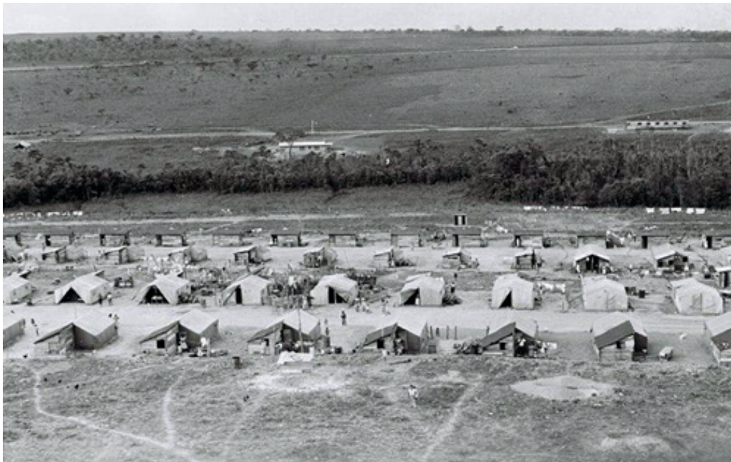
Figura 2. Acampamentos operários na Lonalândia, que mais tarde viria a ser chamada de Candangolândia, em setembro de 1958.
