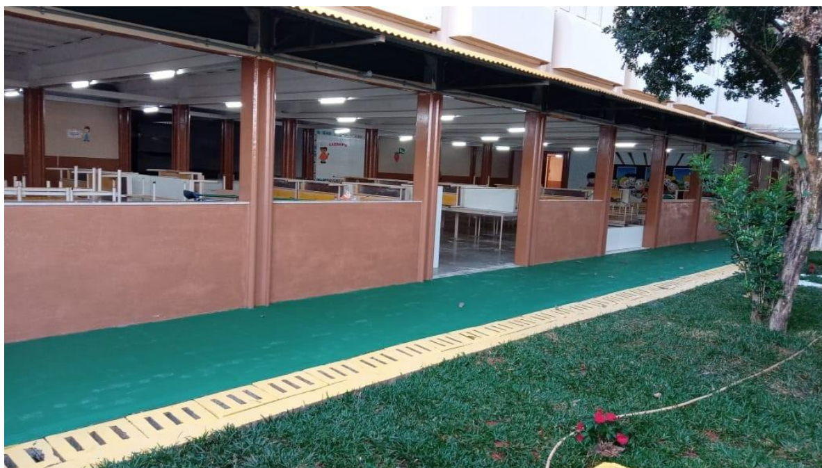
Reforma do Refeitório – 2021
