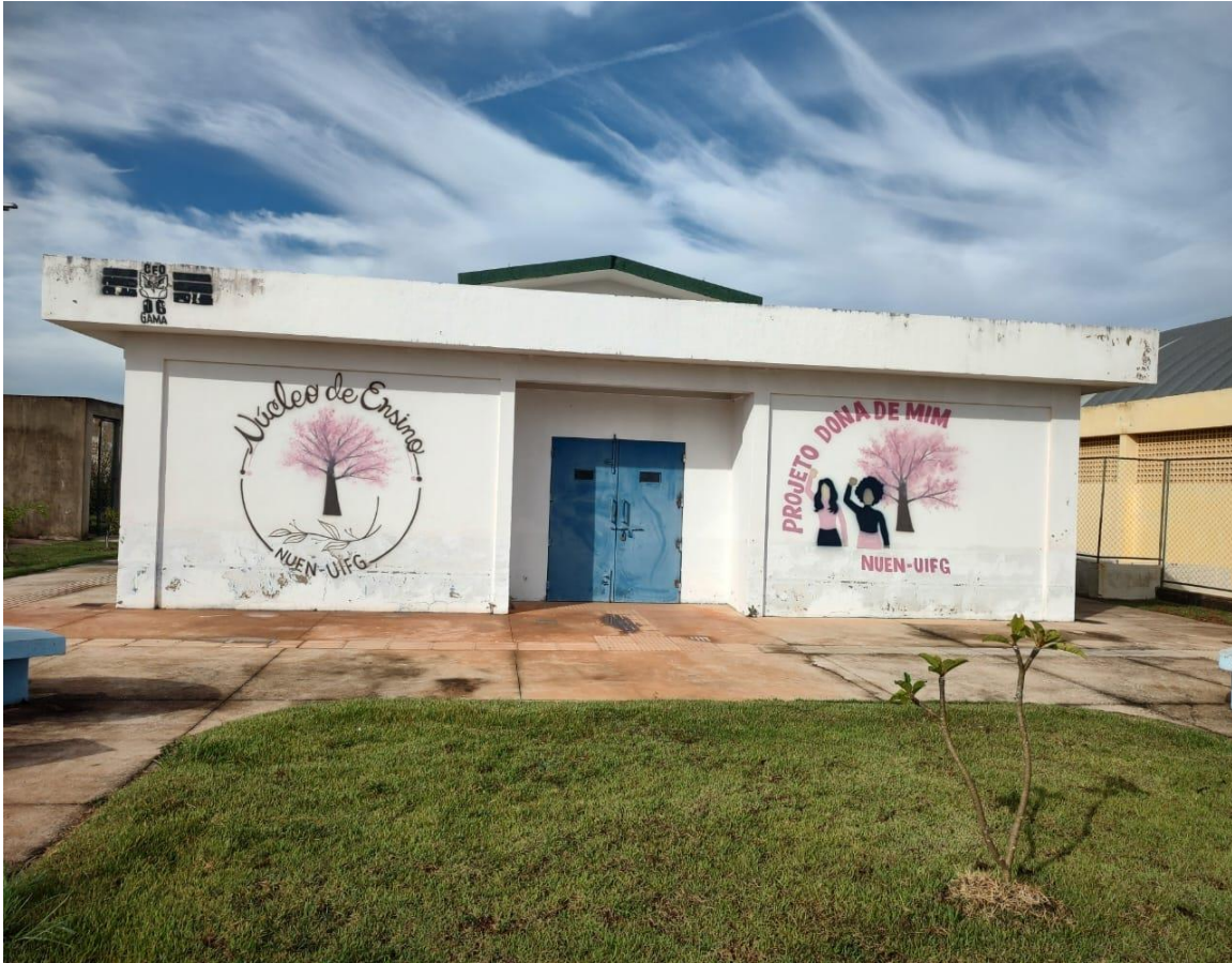
Foto atual – 01- Fachada externa do NUEN
