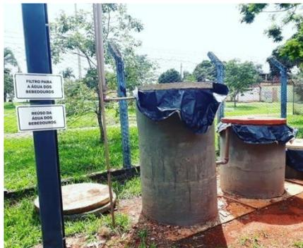
**Reuso da água do bebedouro (2017)** - No sistema de água dos bebedouros foi instalada uma caixa coletora. A água é lançada por bombeamento para uma caixa d'água. No pé da caixa d'água foi instalado um filtro de areia, brita e carvão para eliminar resto de sabão e odor. A água do bebedouro é utilizada para irrigar o jardim, a agrofloresta e o gramado da Exposição Permanente de Tecnologias Sustentáveis.
