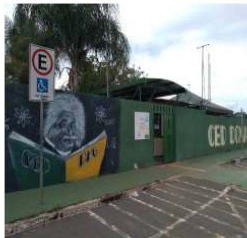
Foto 5 – Portão de Entrada
