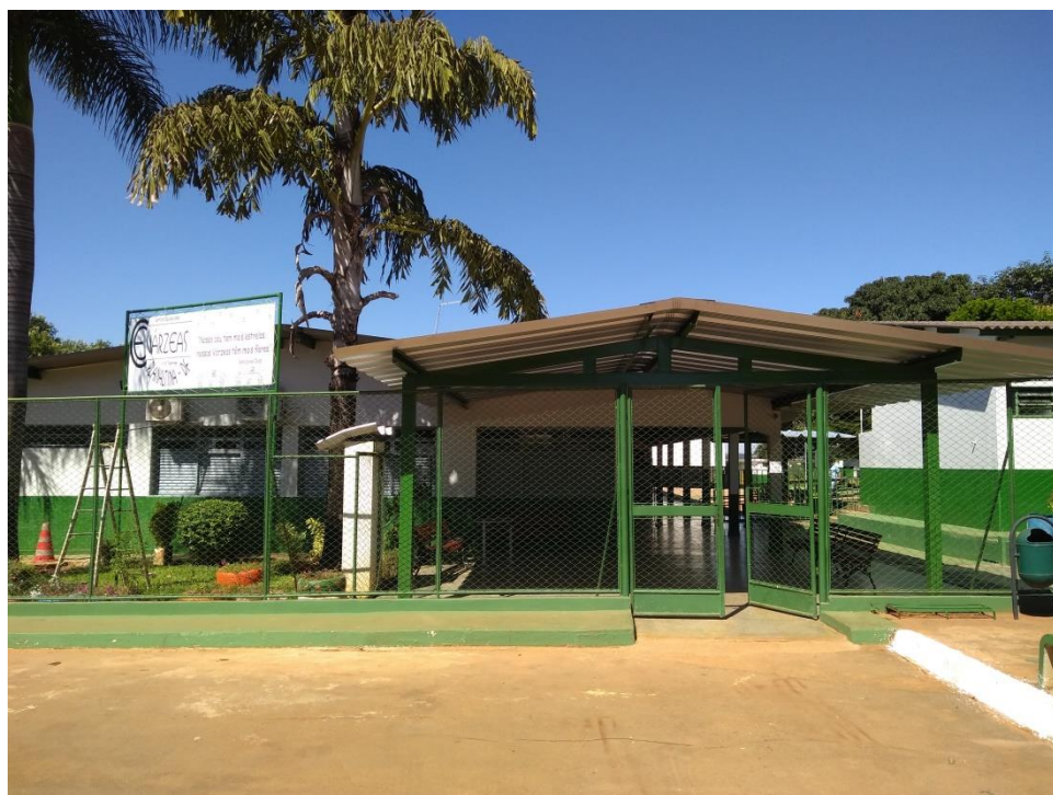
FOTO 4 – Fachada da Escola – 2019.
