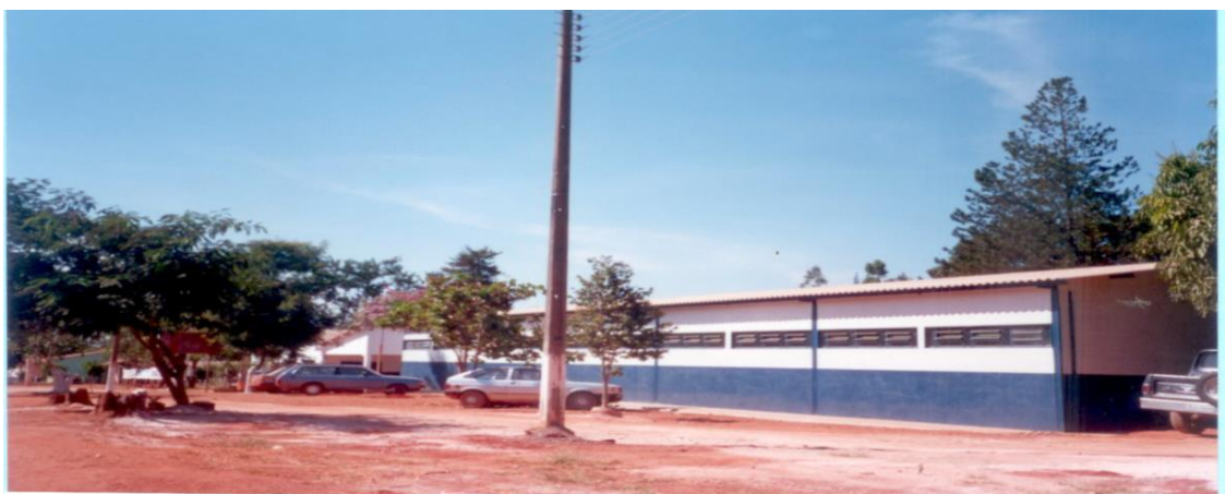
FOTO 3: Vista da ampliação do prédio escolar – ano 2000
