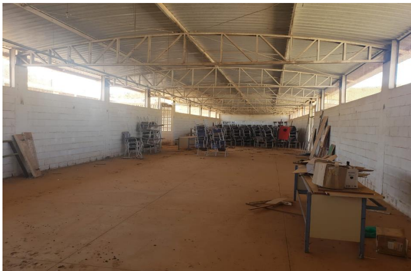
02: Vista interior dos blocos das salas de aula.
