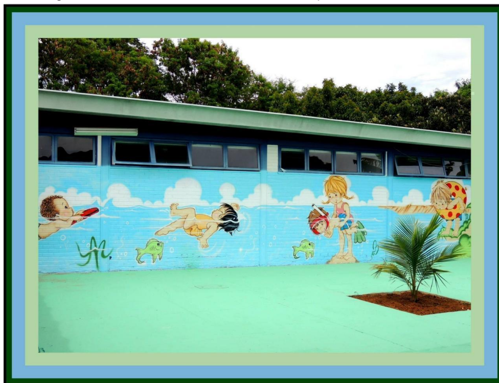
Figura 3 - foto da fachada interna ao lado do pátio da escola.
