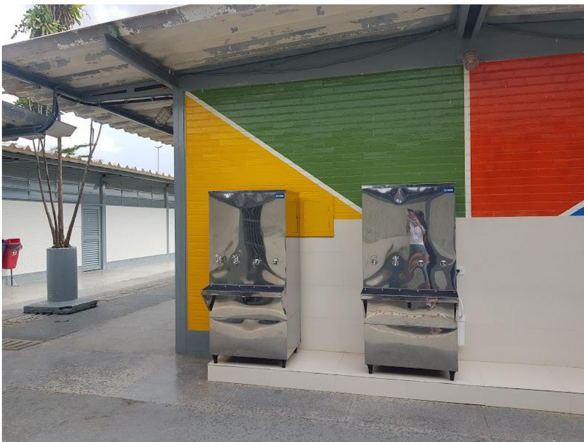
Novos bebedouros com torneira para dispensação da água em copos ou recipientes sem necessidade de aproximação da boca
