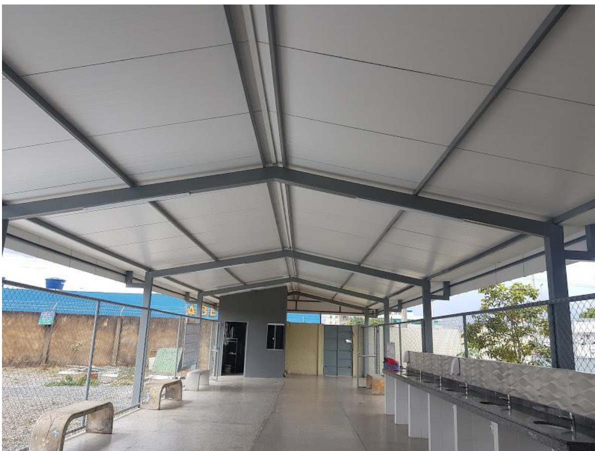
Novo hall de entrada com novas instalações sanitárias
