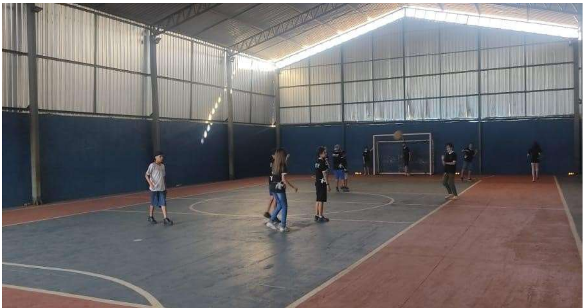
Cobertura da quadra poliesportiva 1
