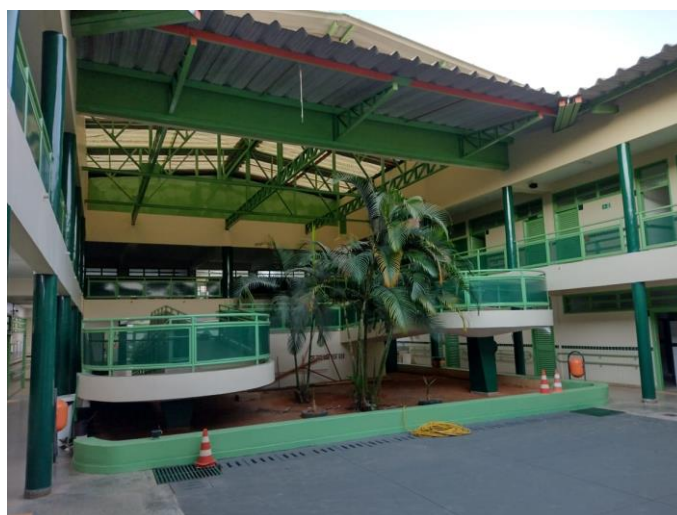
Pintura da área interna e externa
