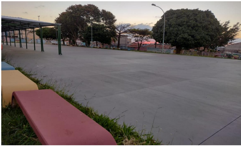
Reforma do Piso do Pátio Externo
