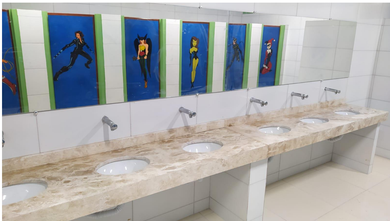
Reforma dos banheiros dos estudantes (2021)
