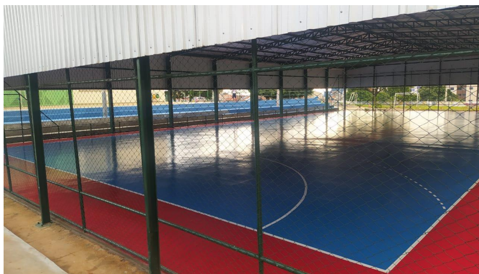
Cobertura da Quadra de Esportes: Pintura
