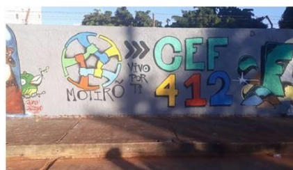
Muro externo da escola
