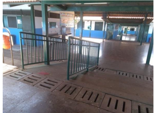
Rampas de acesso - visão da entrada
