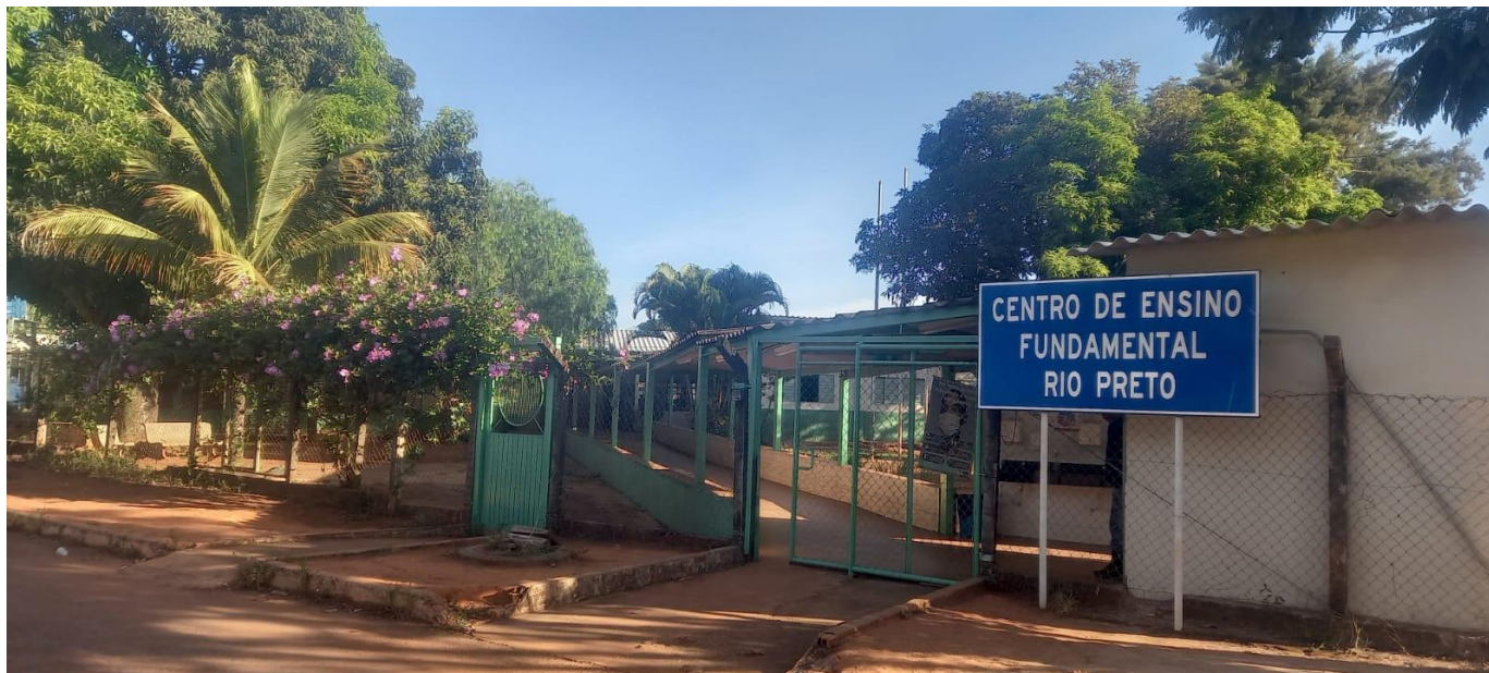
Fachada da escola, foto de 2023.
