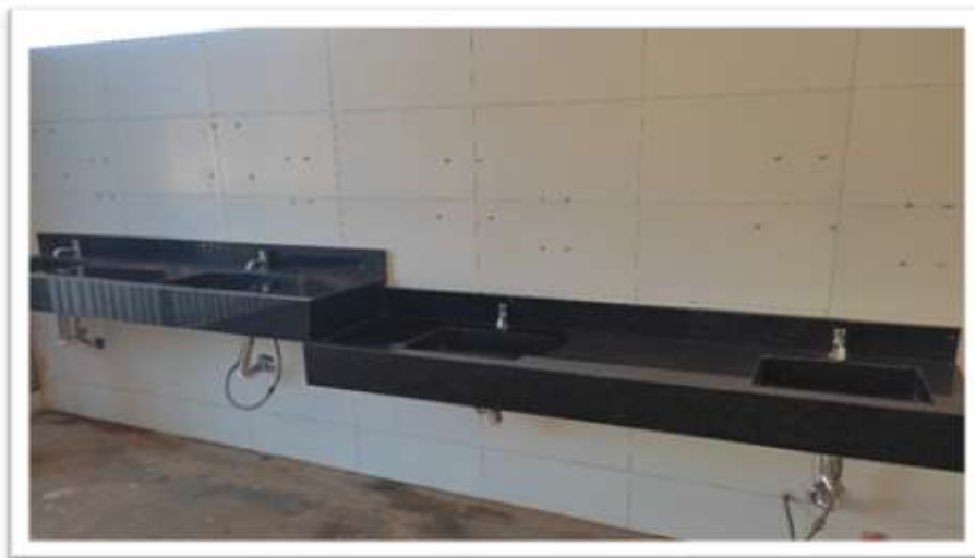
Colocação de cerâmicas a meia parede interno e externamente
