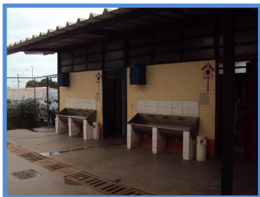
Entrada dos banheiros em 2013
