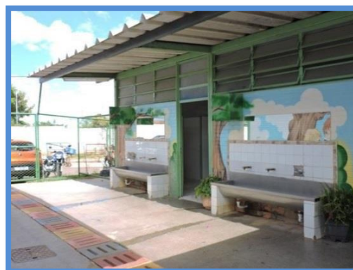
Entrada dos banheiros em 2023
