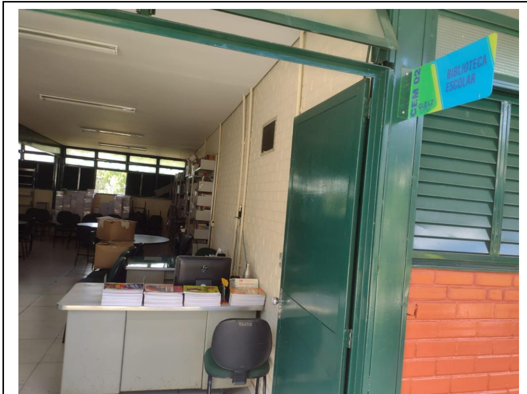
Foto 5 – Porta de entrada da Biblioteca escolar
