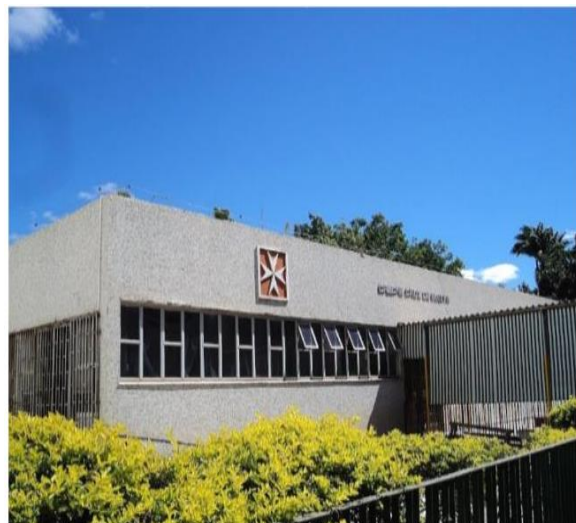
Foto 2: Lateral da creche
