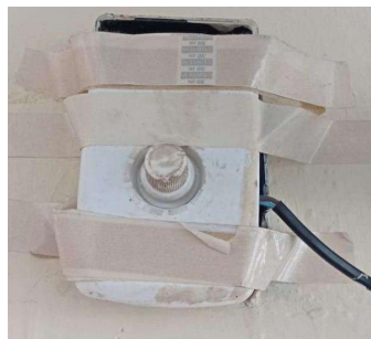
Portas dos banheiros quebradas; tomadas e fios expostos; vasos sem tampa; pintura interna; portão de acesso quebrado.
