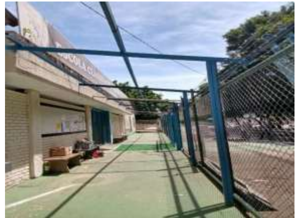
Troca e ampliação do telhado de entrada da escola
