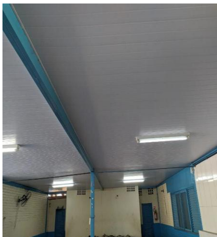
FIGURA 3- FORRO DO PATIO COBERTO
