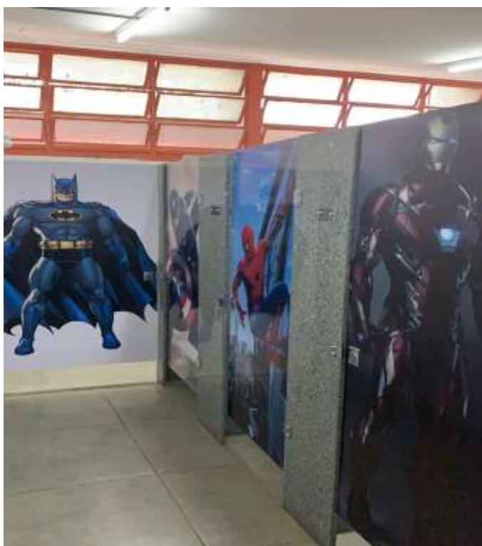
Foto 67 A- Banheiro dos Alunos após reforma
