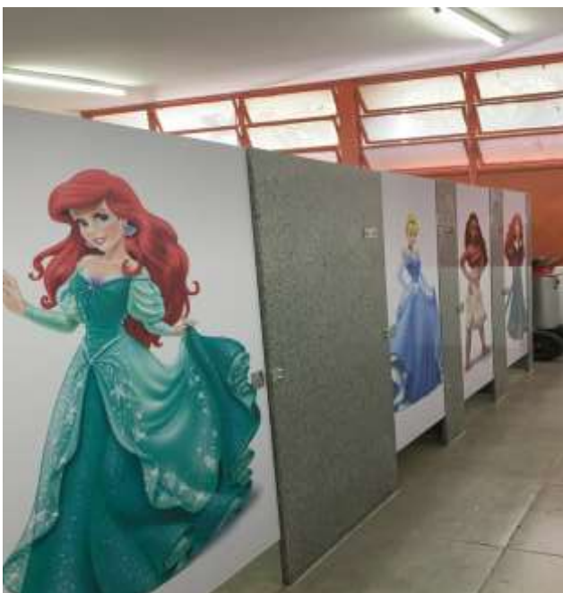
Foto 69 A- Banheiro das Alunas após reforma
