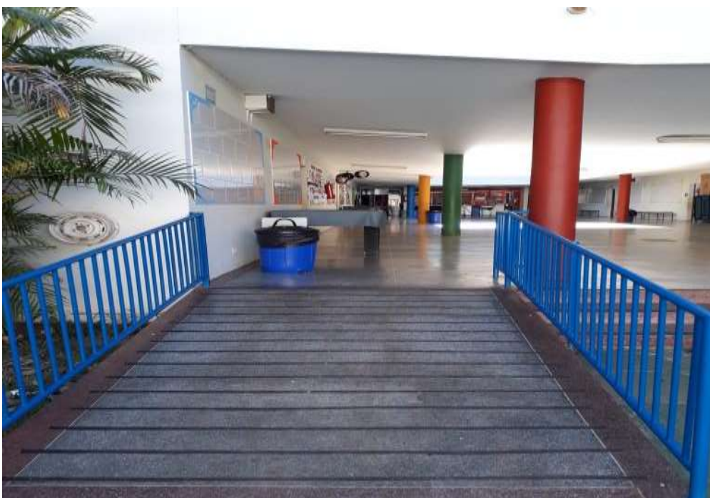
Foto 54- Pátio coberto depois da reforma
