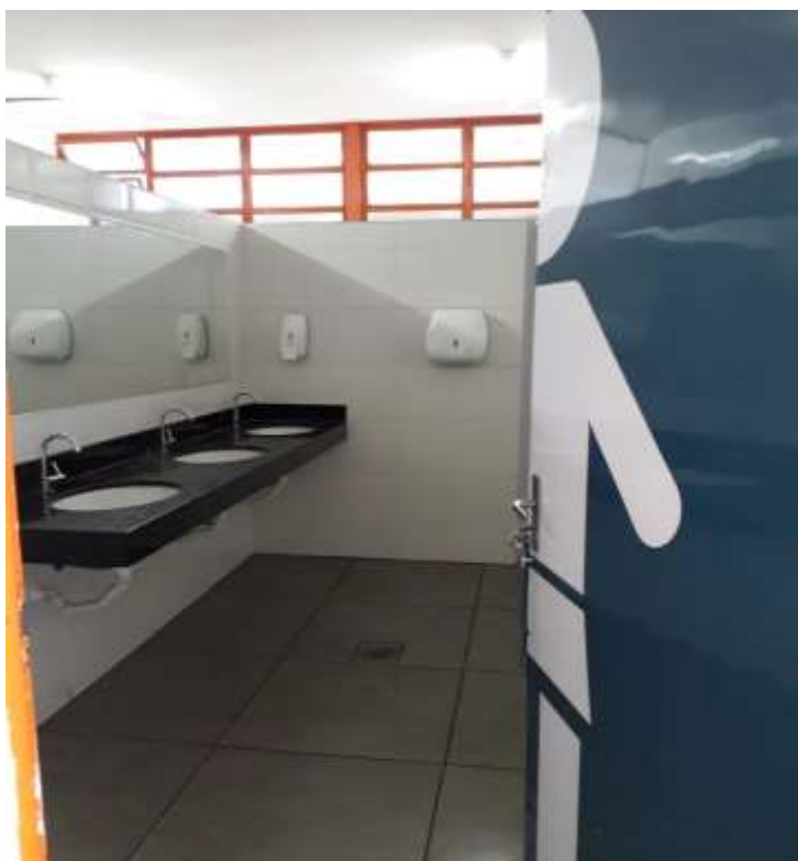
Foto 67- Banheiro dos Alunos após reforma
