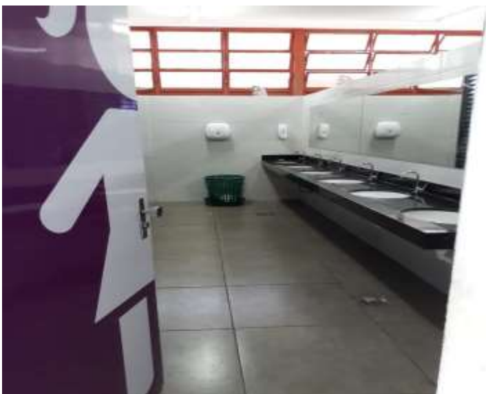
Foto 69- Banheiro das Alunas após reforma
