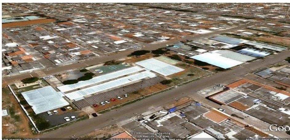
Figura 1 - Escola Classe 46 de Ceilândia – vista aérea
