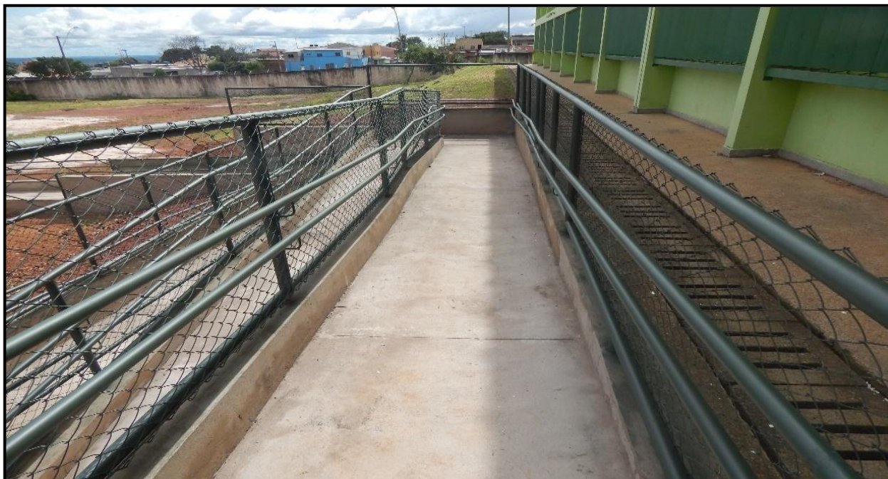
Rampa de acessibilidade
