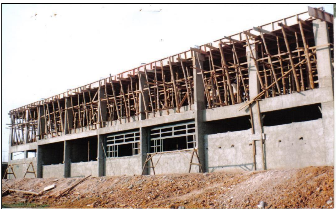
Vista do CRA - Escola Classe 501 de Samambaia - DF, em construção, 2005
