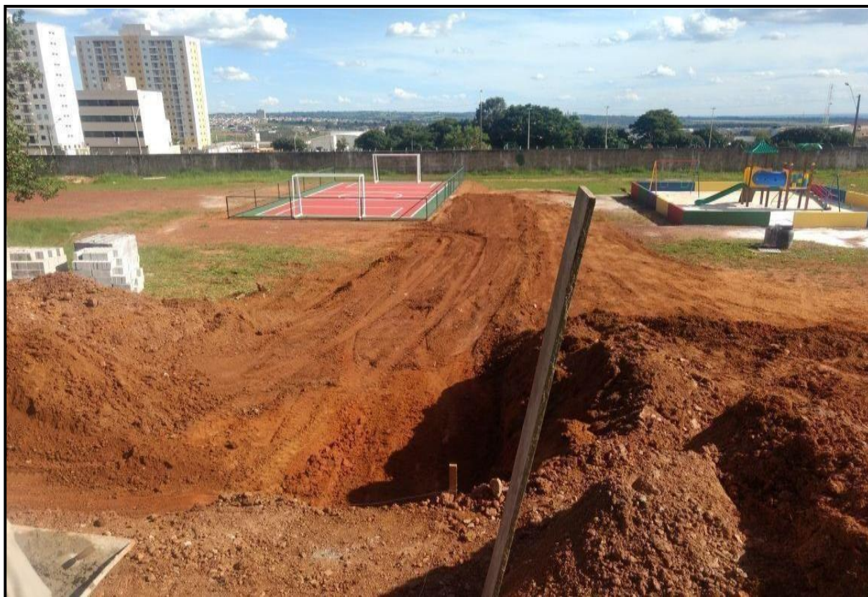
Parquinho e Quadra de esporte em construção
