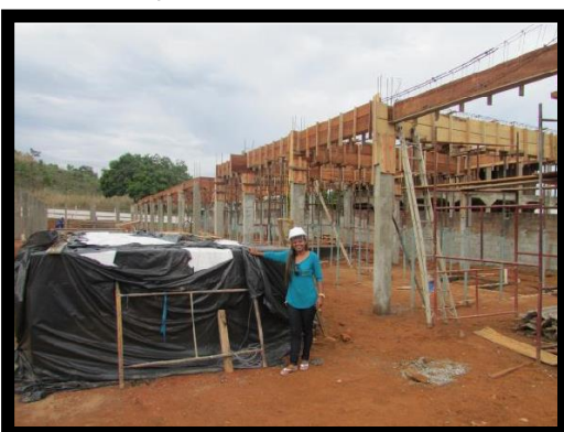
Figura 15: Novo prédio construção e andamento. Autoria própria.
