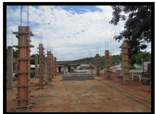
Figura 14: Novo prédio – construção e andamento. 2013. Autoria própria.
