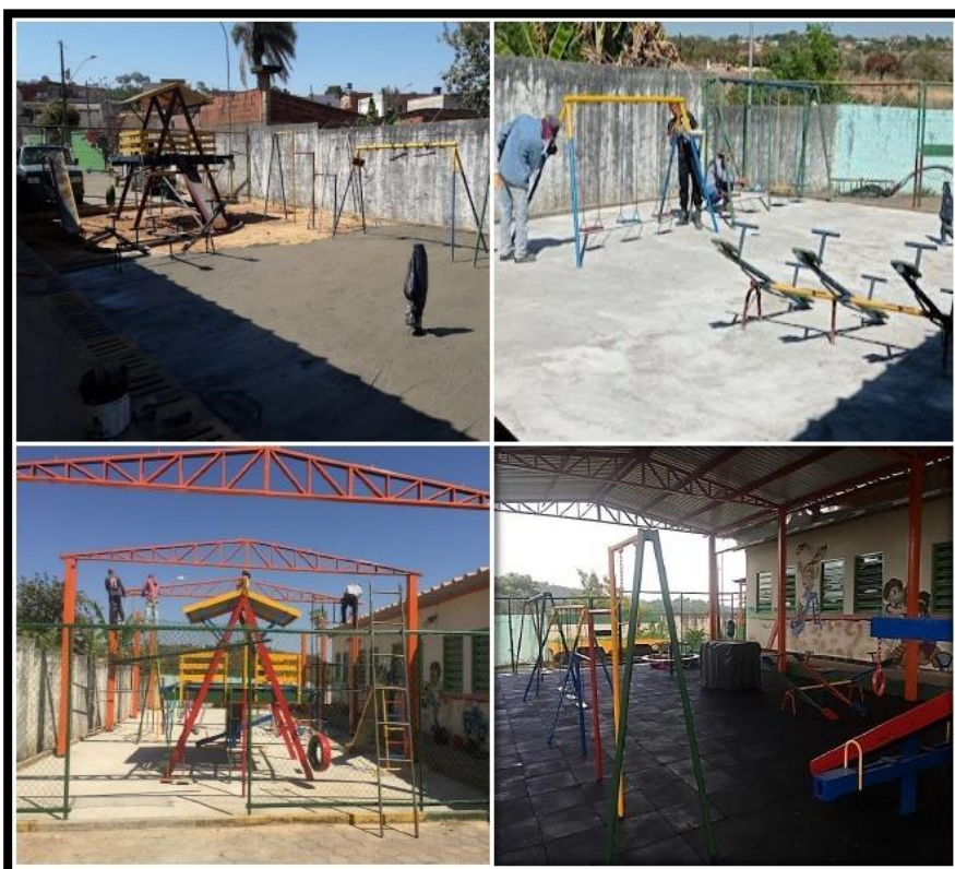
Figura 26 Reforma do parque, em 2021.
