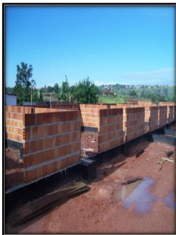
Figura 12 Em 2008, início da reconstrução da Escola
