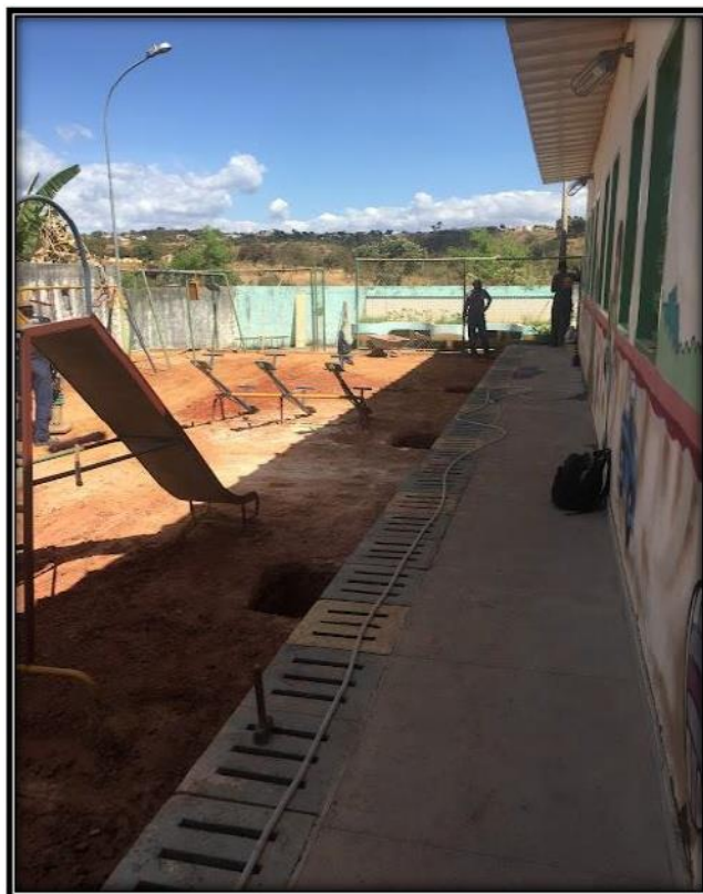
Figura 25 Parque sendo reformado, em 2021.
