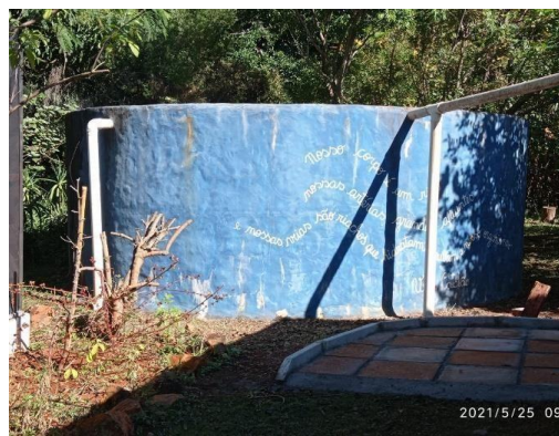
Tanque de Captação de Água da Chuva
