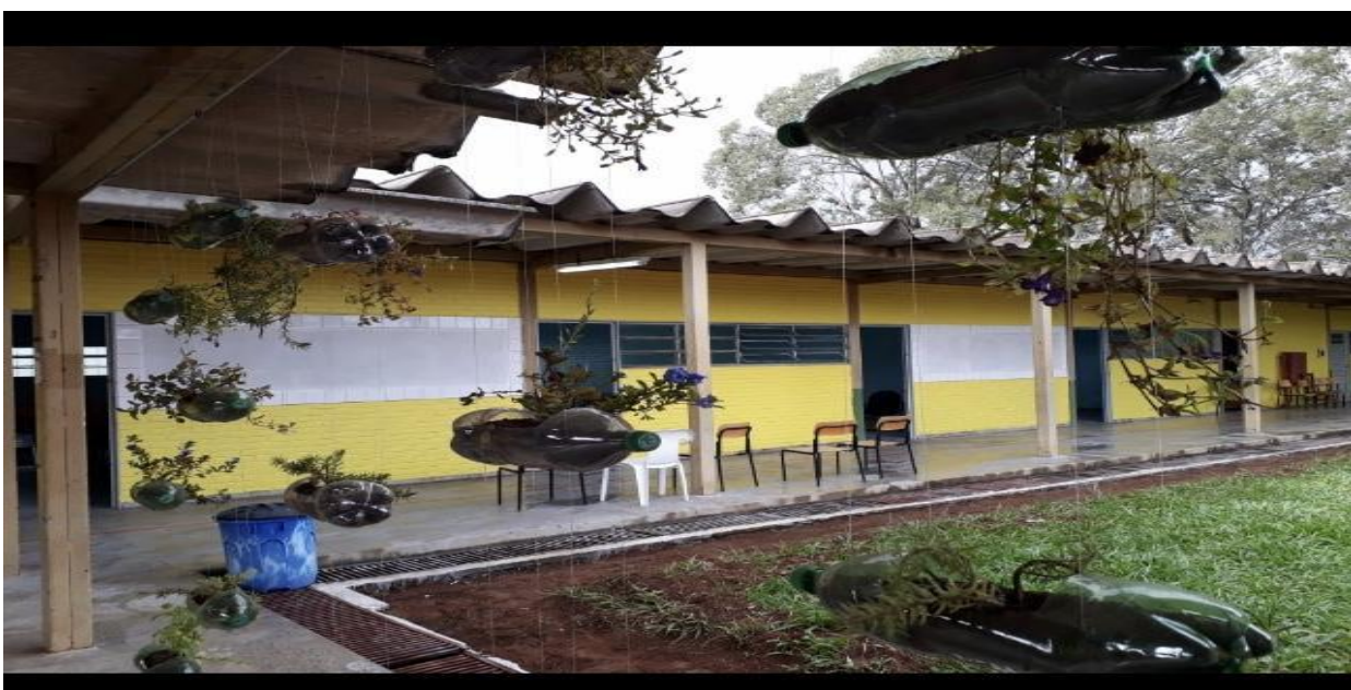
Foto atual – 01- Fachada Interna do Bloco A
