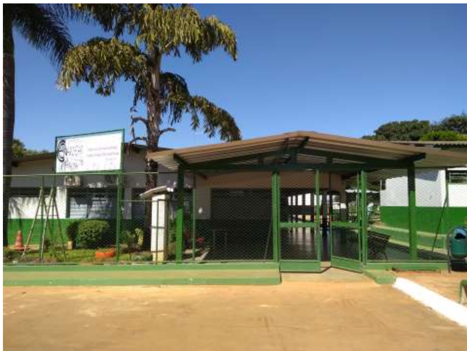
FOTO 4 – Fachada da Escola – 2019.
