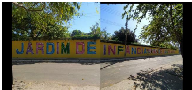
06/0622 - FACHADA/ MURO COM O NOME DA ESCOLA JI116
